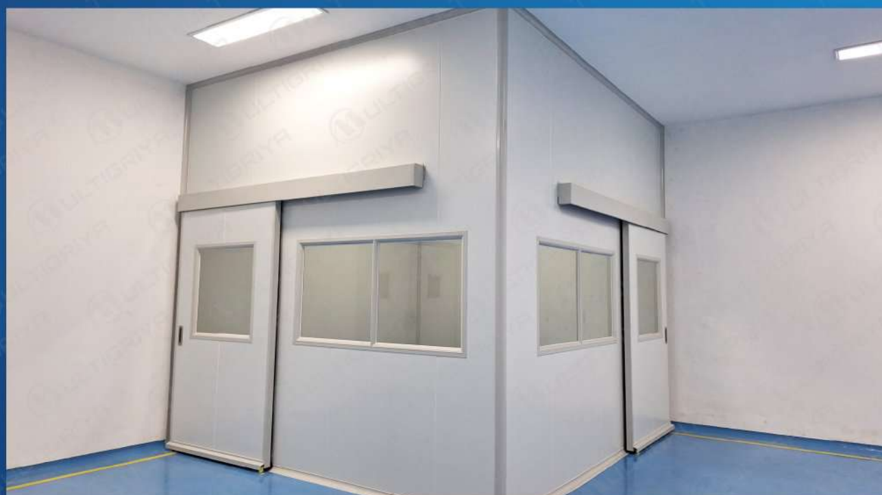
PT. GMI, Banten Project Clean Room Pabrik Alat Kesehatan
