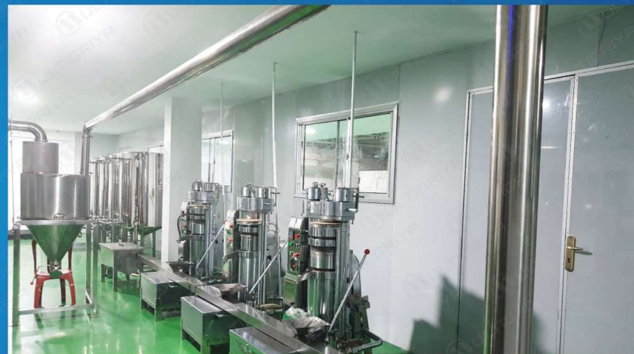
PT. SKB, Jawa Barat Project Clean Room Pabrik Alat Kesehatan
