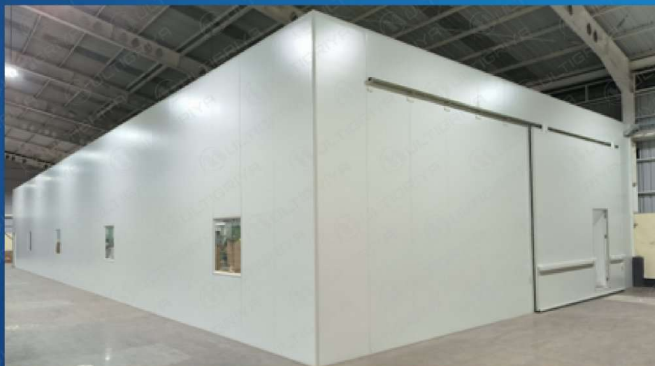
PT. STI, Banten Project Clean Room Ruang Mesin Produksi
